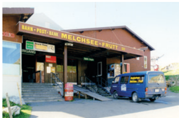
Bergstation Gondelbahn nach Umbau 1973
