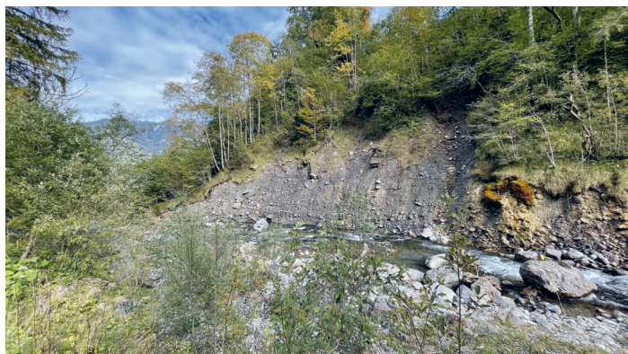
Uferböschung im Bereich Gerigsmatt - Oktober 2021
