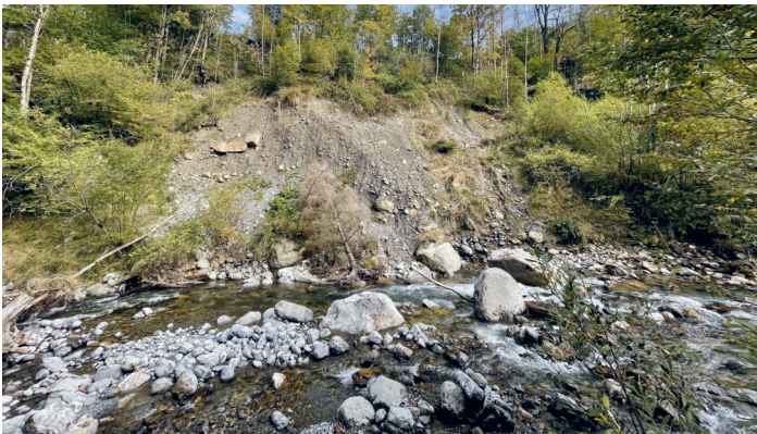
Uferböschung im Bereich Tumlibach - Oktober 2021
