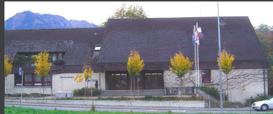
Blick von der Sarnerstrasse vor der Renovation
