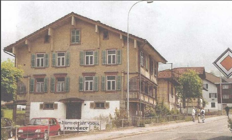
Wohnhaus und Ökonomiegebäude der «Pfister Franzänä», Nordwestseite, Merkmale des Schweizerhausstils, Laubsägeornamente. Die Lauben wurden zu Balkonen umgebaut.
