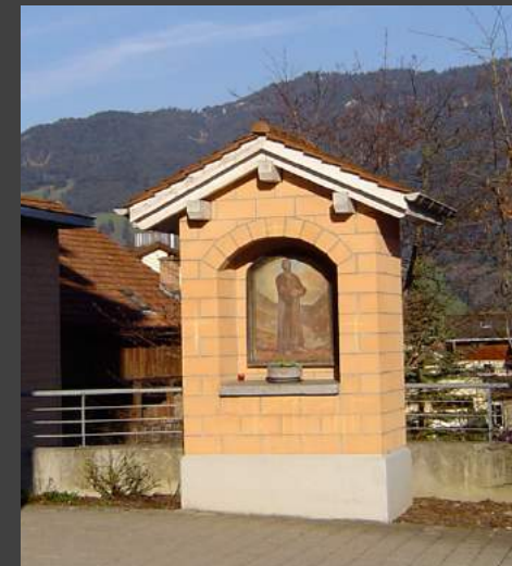
Das Helgenstöckli rechts neben dem Hauptgebäude mit Bild von Bruder Klaus
