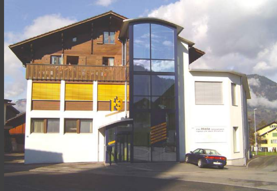
Bürogebäude der Holzbau Bucher AG, erbaut von Josef Bucher-Rüttimann, Untergasse 11
