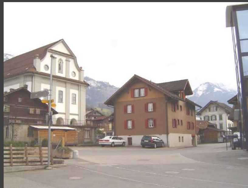
Parkplatz mit „Sigristenhaus“ rechts, Untergasse 12
