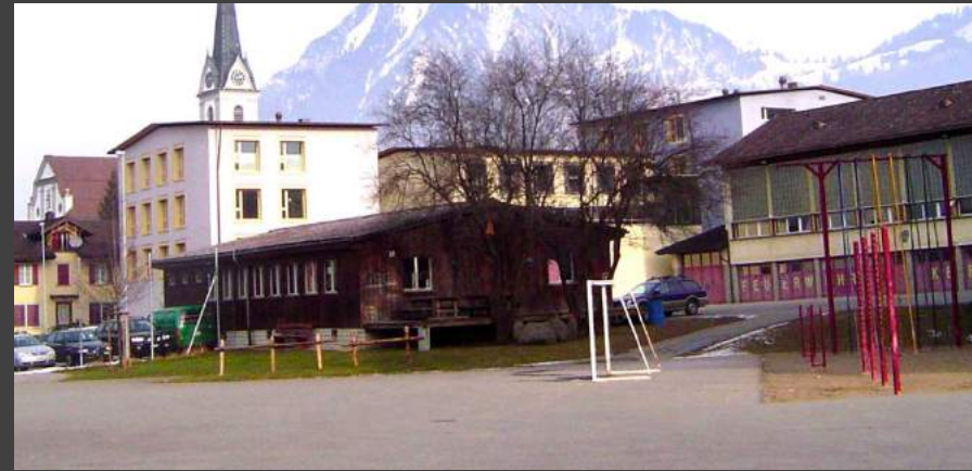
Pavillon, 1964 im Auftrag der Bürgergemeinde errichtet, ehemaliges Provisorium des Gemeindehauses, Schulzimmer und später Jugendraum „Willa“ und Jugendbüro, im Hintergrund Zentrumsüberbauung und alte Turnhalle, von Süden
