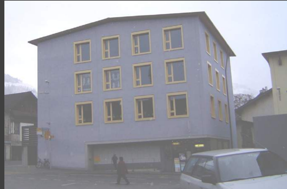
Zentrumsüberbauung, Haus 1, Postplatz 2 Architekten: E. Imhof und M. Imhof-Dorn Kunst am Bau (links) „Energiezentrale“ schuf Joe Achermann
