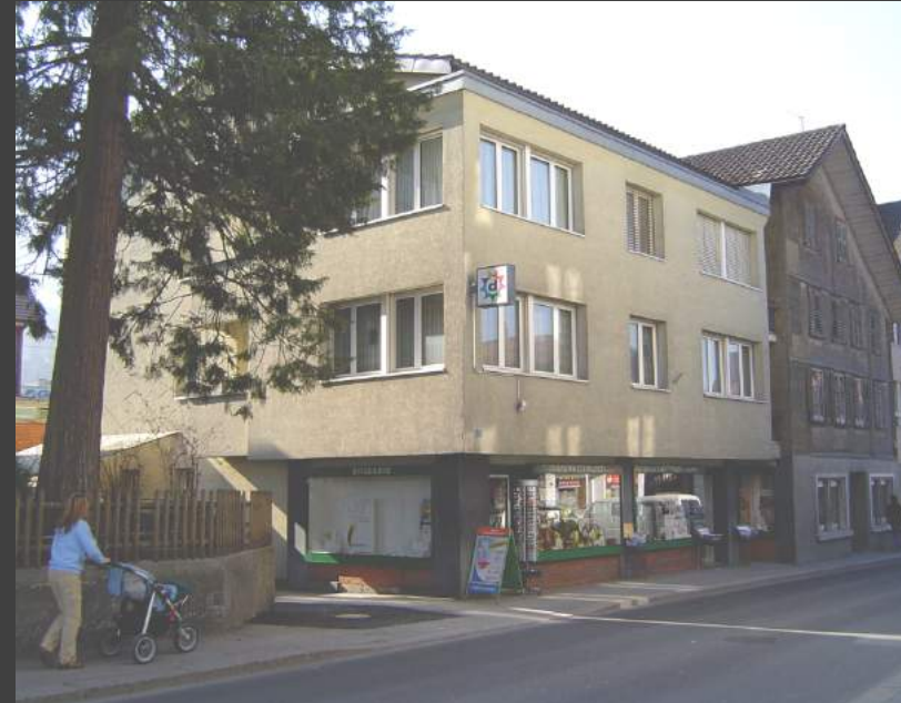
Ehemalige Drogerie Windlin, Neubau nach dem Brand, Dorfstrasse 16 Erhaltener Hausteil rechts: Wolle- und Mercerie-Laden von Béatrice Egger, Dorfstrasse 14
