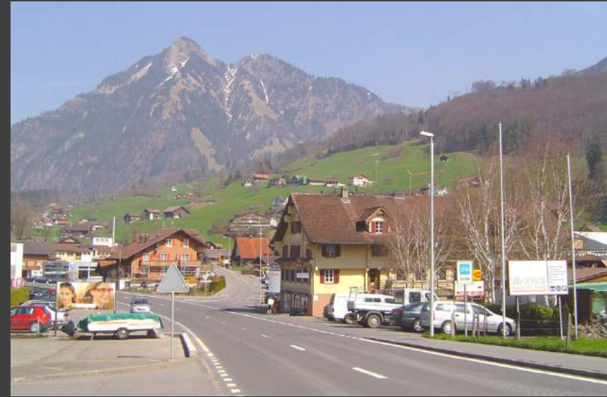
Gasthaus zum Sand und Camping Sand, Stanserstrasse 100, abgebrochen
