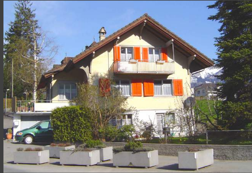
Wohnhaus von „Polizist Huwyler“, Abendweg 2
