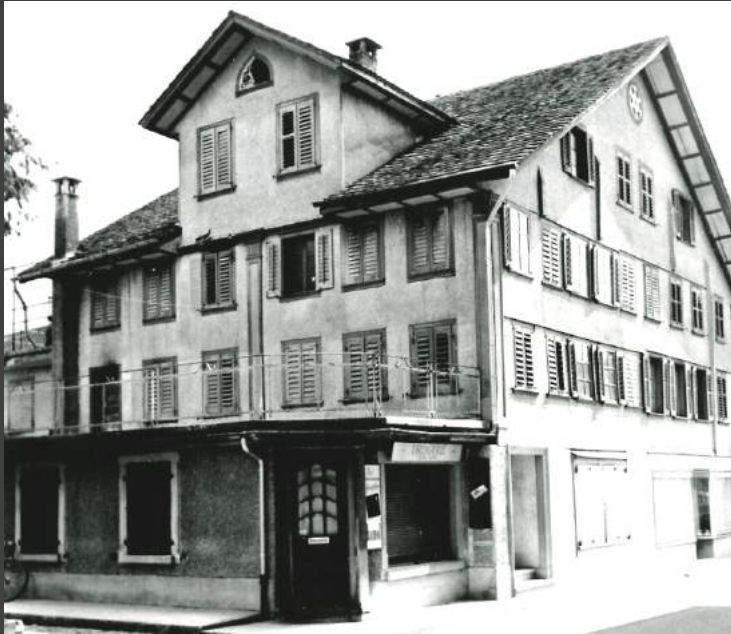
Haus von Forstverwalter Otto Durrer-Spichtig, 1878-1960, und Ignaz Egger, Sattler. Im Anbau links, führte Hans Ming-Durrer seine Drogerie. Der linke Hausteil von Otto Durrer wurde durch einen Brand stark beschädigt und musste abgebrochen und durch einen Neubau ersetzt werden.
